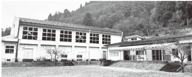
山田体育館解体前 ※2025年12月24日撮影
