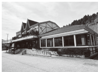
改修予定の小代物産館
