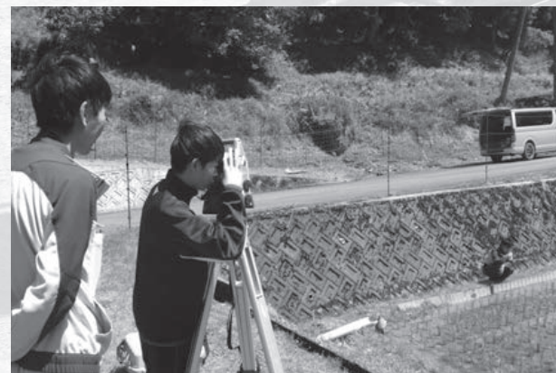
今後建設棟では、村岡中学校の生徒が測量に挑戦しました。
