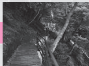
▲転落防止柵が設置された遊歩道
