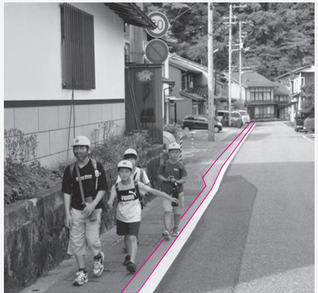
▲実線部分にグリーンベルトを設置し安全性を向上
