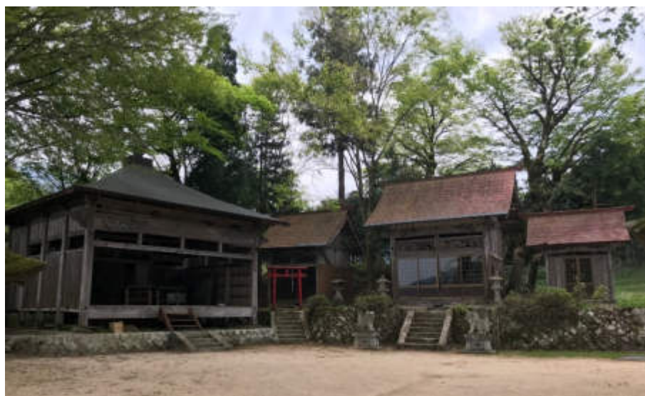
町指定文化財 貫田 八幡神社 本殿、稲荷社、薬師堂
