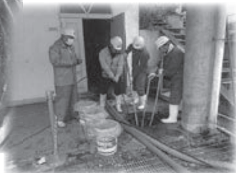
▲詰まりの解消作業をしている様子
