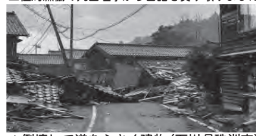
▲倒壊して道をふさぐ建物（石川県珠洲市）
