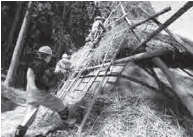
▲連携してかやぶき屋根の修繕を進める作業員ら
