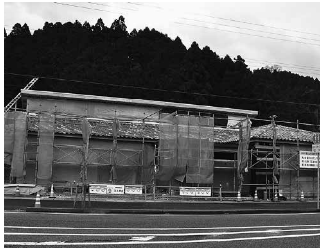
建設中の「ディライト香住山手」
