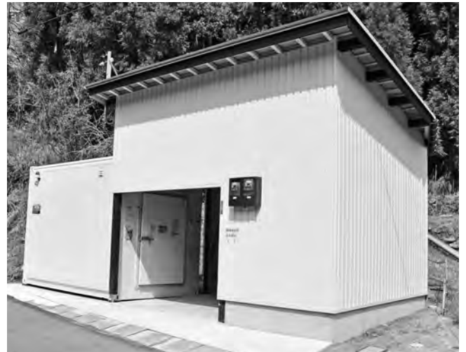
鹿の一時冷凍保管施設
