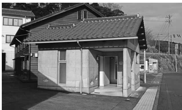
いつもきれいな柴山港公衆トイレ
