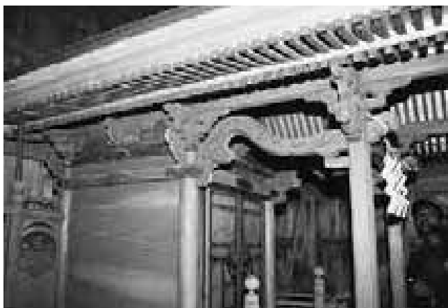
図217 八坂神社本殿側面
