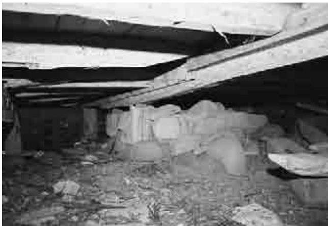
図197 薬師堂床下の囲炉裏の石組
