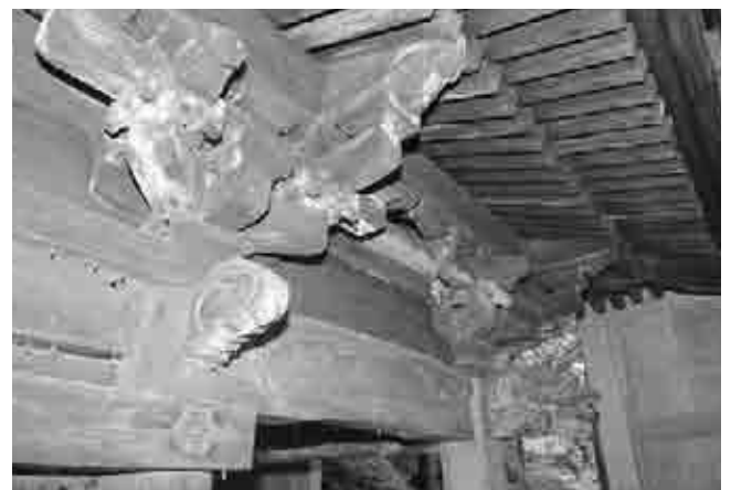
図565 吉滝神社本殿側面組物
