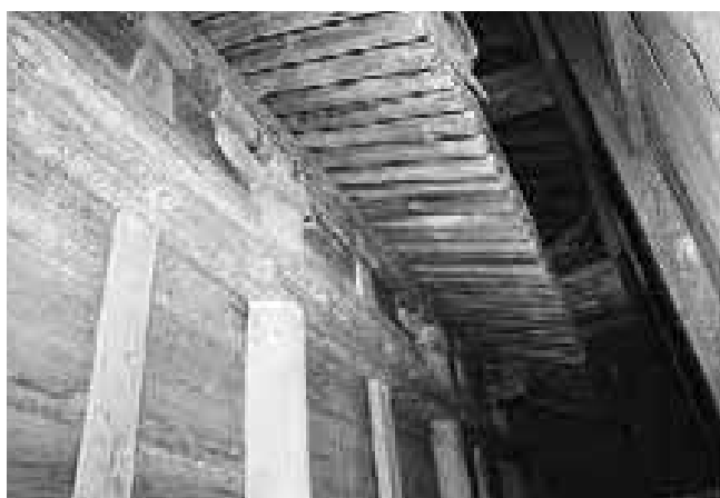
図278 郡主神社本殿背面
