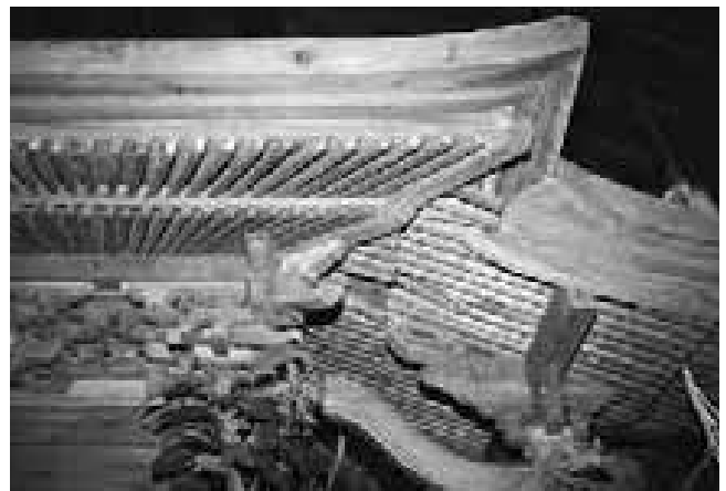
図139 八柱神社本殿軒
