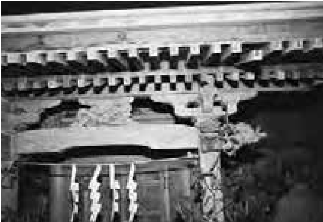
図200 三柱神社本殿庇
