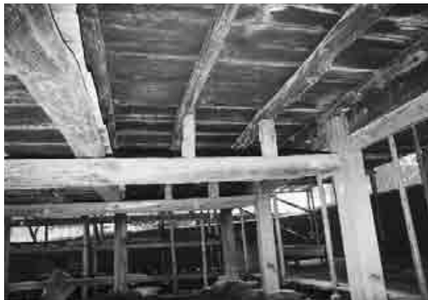
③ 解体状況
