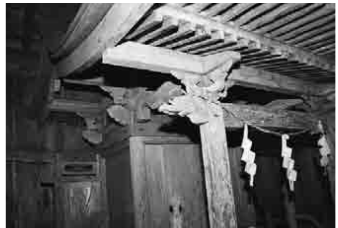
図271 相田神社旧本殿庇
