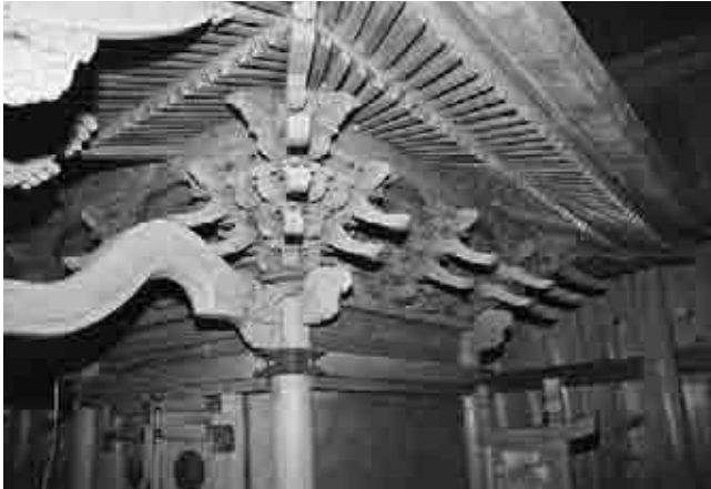
図228 八柱神社本殿本体部
