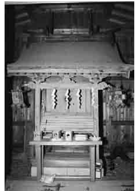
図231 美伊神社本殿全景
