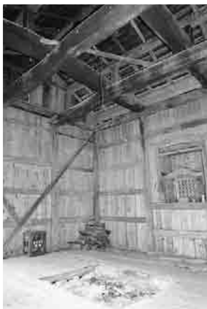
図492 八幡神社堂内部
