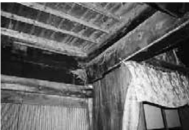
図408 観音堂内部架構
