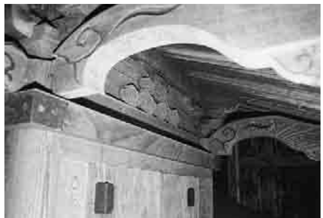
図502 荒霊神社本殿身舎
