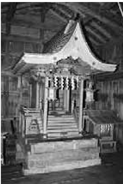
図212 八坂神社本殿全景
