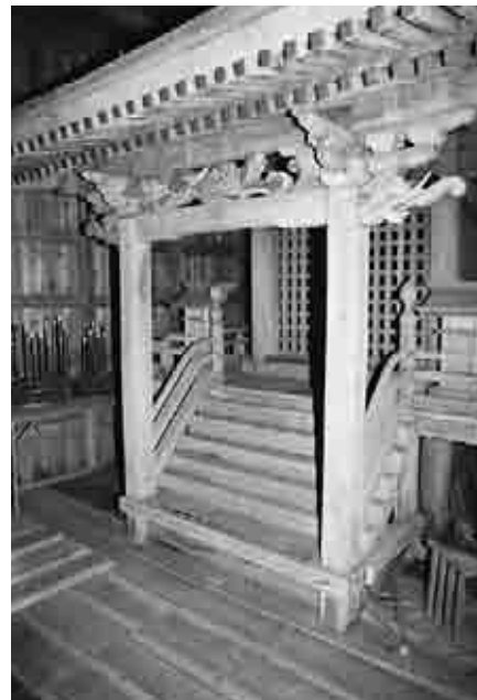
図130 八柱神社本殿底正面
