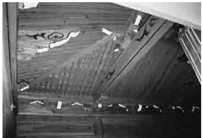
図69 大乘寺観音堂外陣隅見上げ
