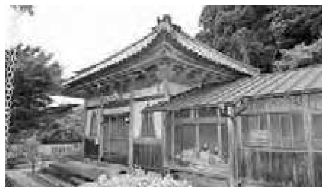
図19 通玄寺薬師堂全景
