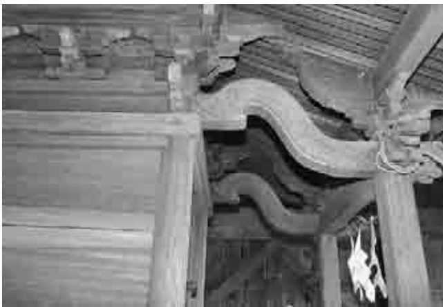
図572 八幡神社本殿庇見返し
