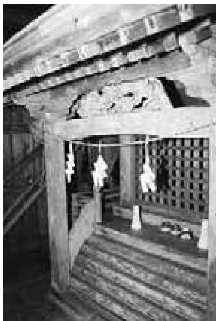
図476 山ノ神本殿庇正面
