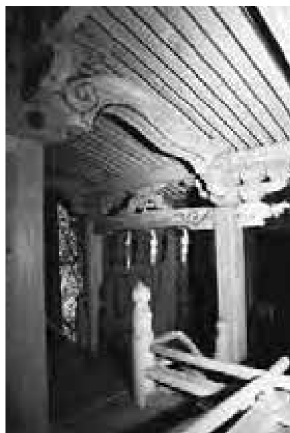
図460 八幡神社本殿庇見返し
