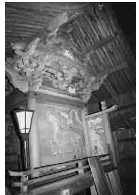
図165 八幡神社本殿身舎右側面
