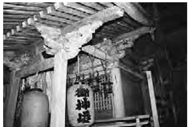
図275 郡主神社本殿側面
