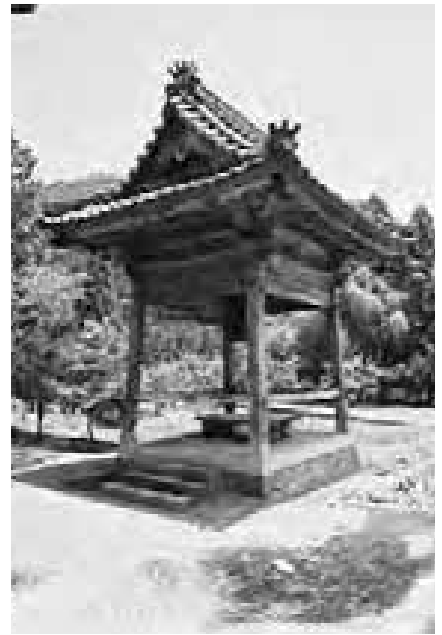
図189 遍照寺鐘楼全景
