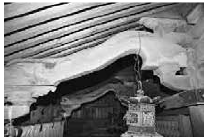
図242 十二社神社本殿繫海老虹梁
