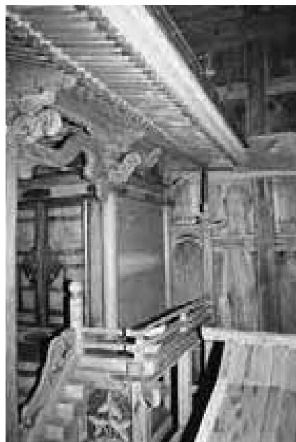
図213 八坂神社本殿側面
