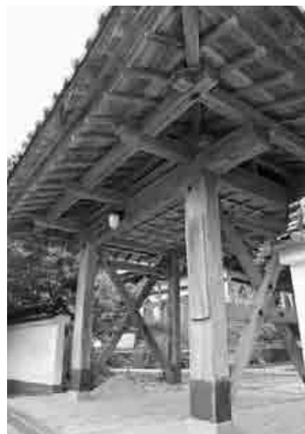
図18 通玄寺山門正面見上げ
