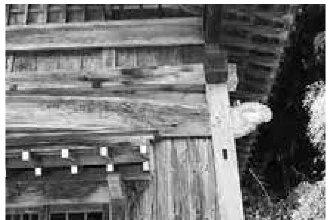
図470 お堂正面虹梁形飛貫
