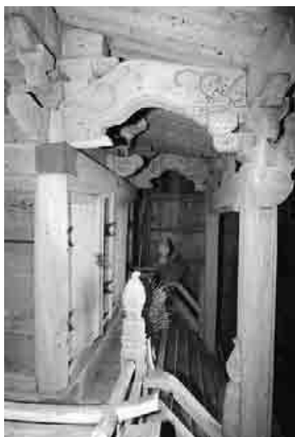
図489 八幡神社本殿庇
