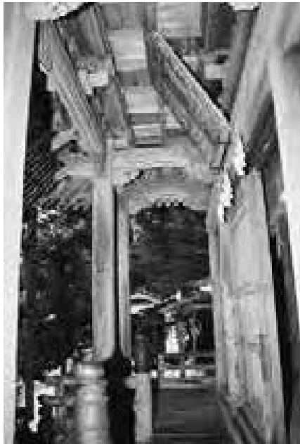
図264 黒野神社本殿吹き放ち部分
