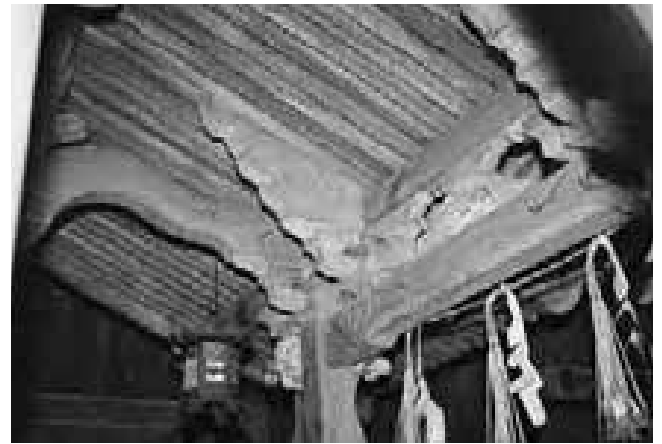
図162 八幡神社本殿庇見返し
