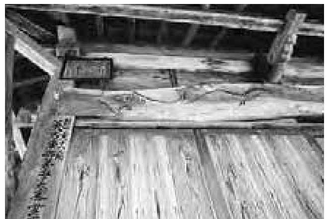
図302 薬師堂正面虹梁形内法貫
