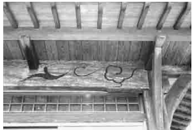
図601 観音堂正面虹梁形飛貫
