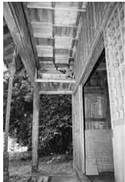
図193 薬師堂正面吹き放ち部分
