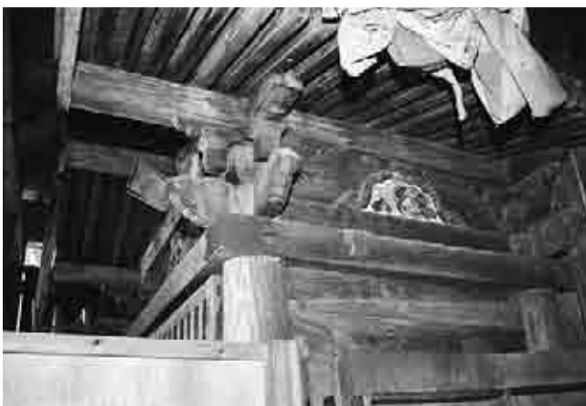
図582 八幡神社薬師堂厨子側面
