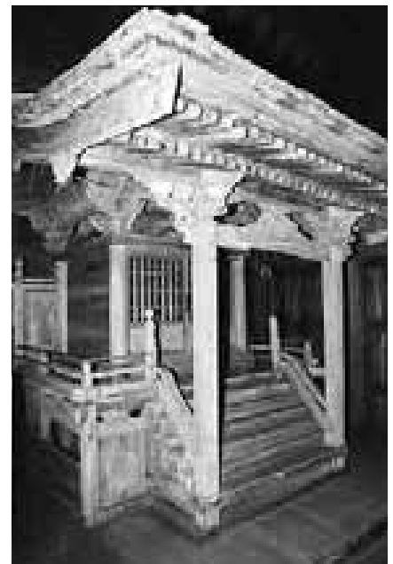
図359 八坂神社本殿全景
