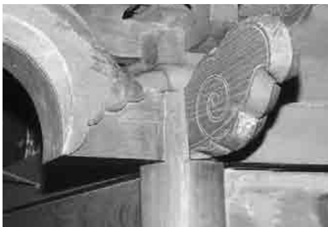
図314 寺河内神社本殿身舎頭貫木鼻
