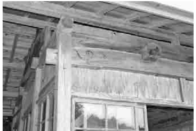
図622 観音堂正面虹梁形飛貫
