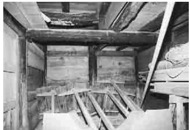
③ 本殿床下
