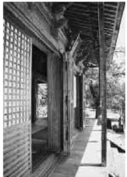
図175 遍照寺観音堂正面
