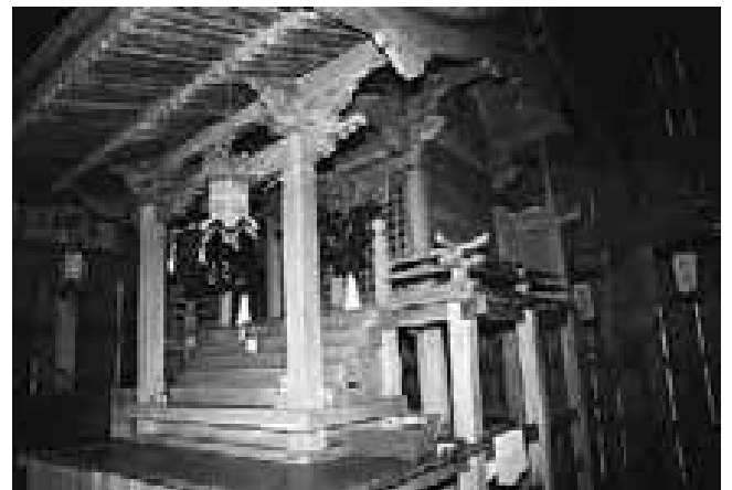
図296 高井神社本殿全景
