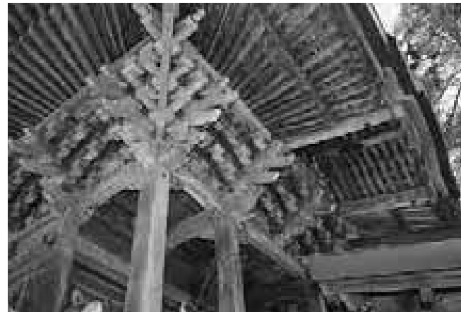
図267 黒野神社本殿正面見上げ
