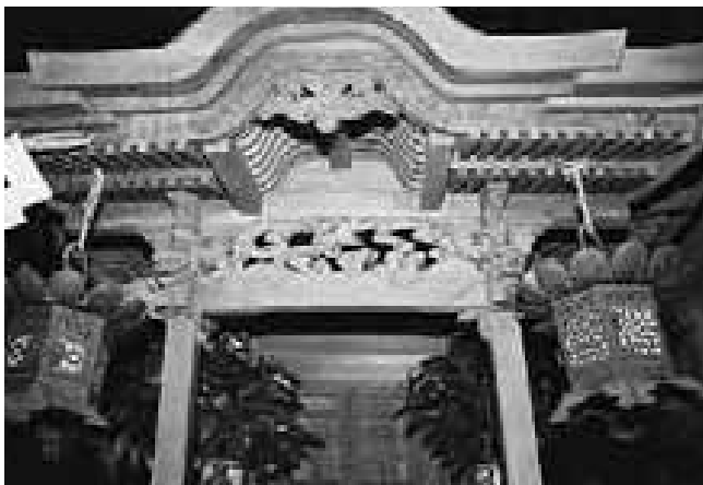
図137 八柱神社本殿庇正面
