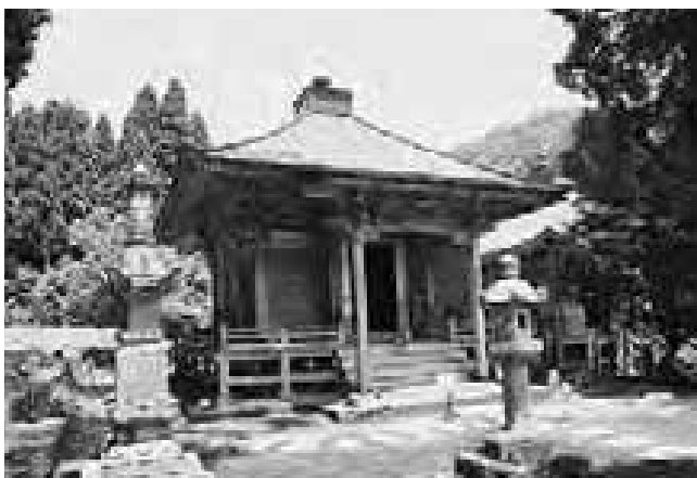
図181 遍照寺大師堂全景
