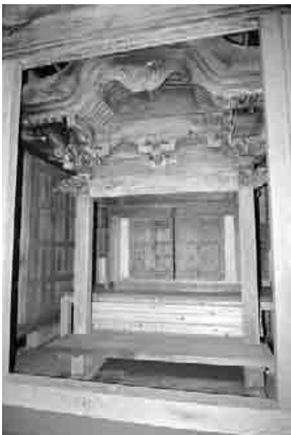
図561 吉滝神社本殿全景
