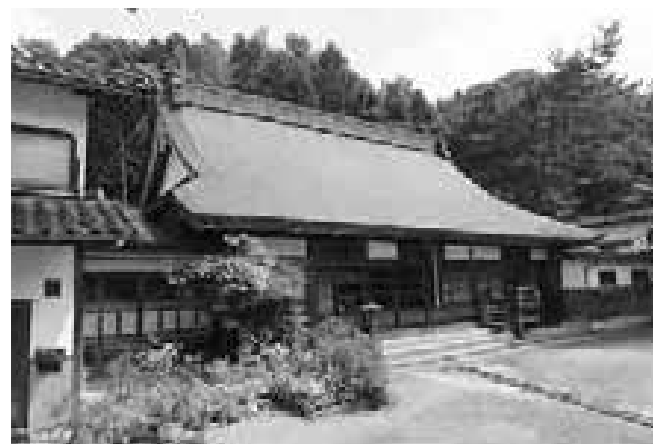
図316 善性寺本堂全景
