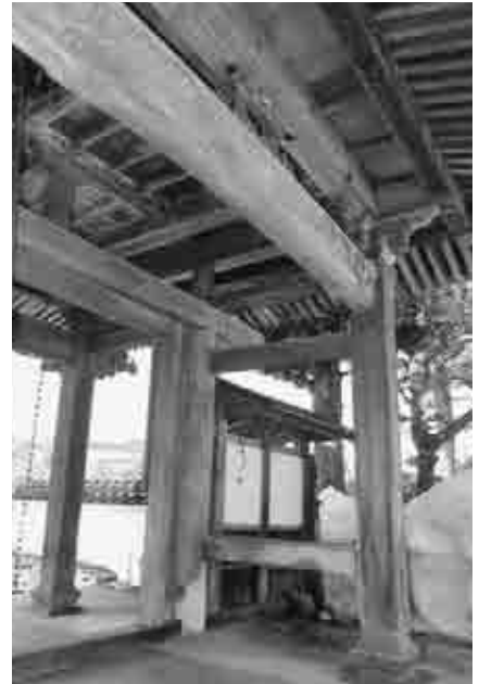
図518 光明寺山門下層内部
