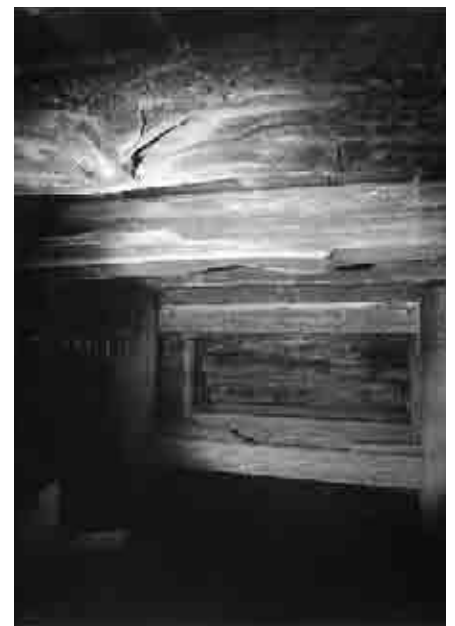
③ 本殿床下
