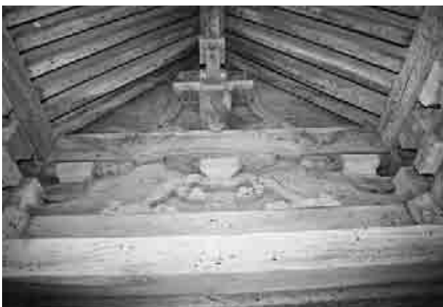
図134 八柱神社本殿妻飾
