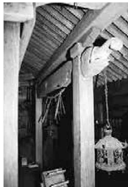
図437 八幡神社本殿庇見返し
