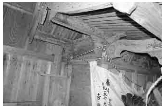
図506 野間谷神社本殿側面
