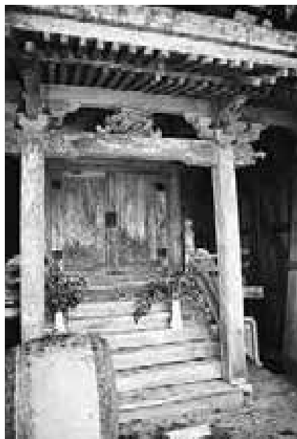
図495 荒霊神社本殿正面
