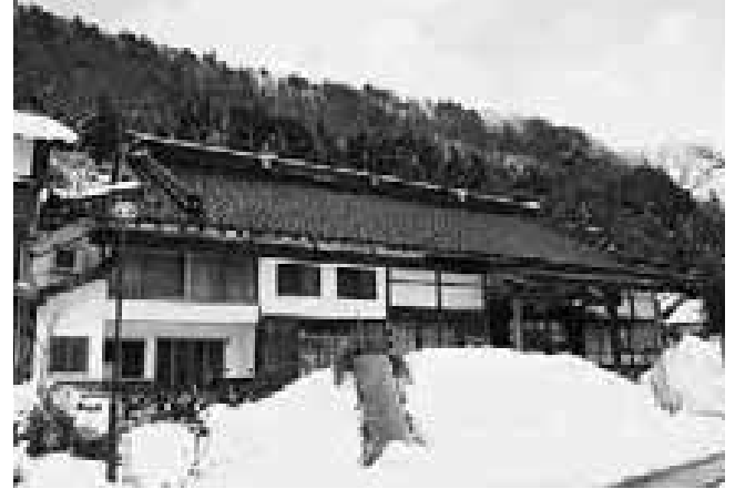
図249 大運寺本堂全景
