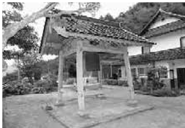
図323 善性寺鐘楼全景
