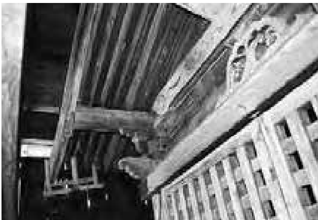
図581 八幡神社薬師堂厨子正面
