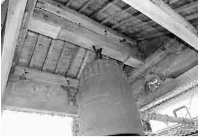
図324 善性寺鐘楼内部
