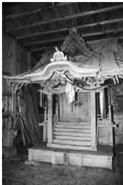
図142 大倉神社本殿全景
