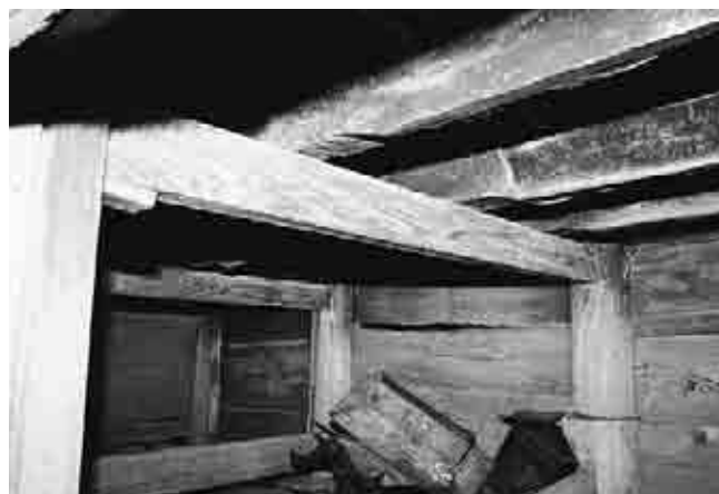
図282 郡主神社本殿床下
