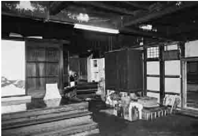
図53 大乘寺客殿及び庫裏土間
