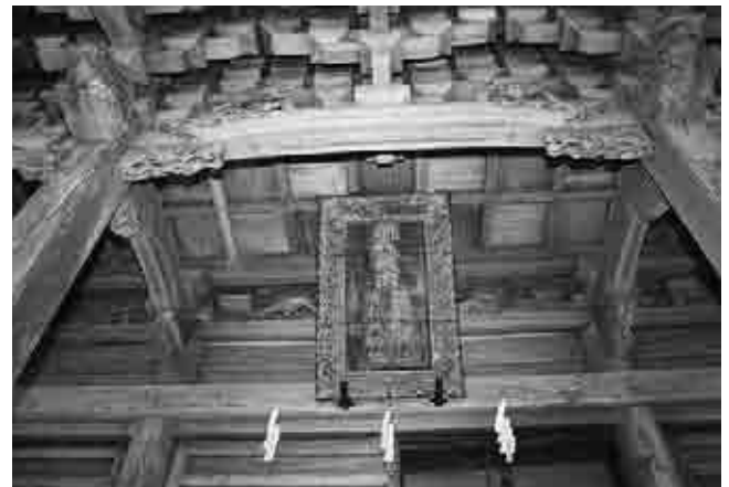
図268 黒野神社本殿吹き放ち部見上げ
