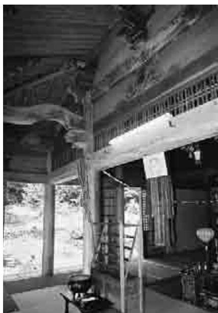
図176 遍照寺観音堂内外陣境
