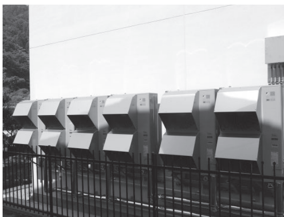
▲余部小学校のエアコンの室外機
