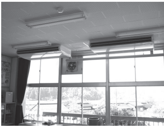
▲エアコン設置により快適な学習環境を整備
