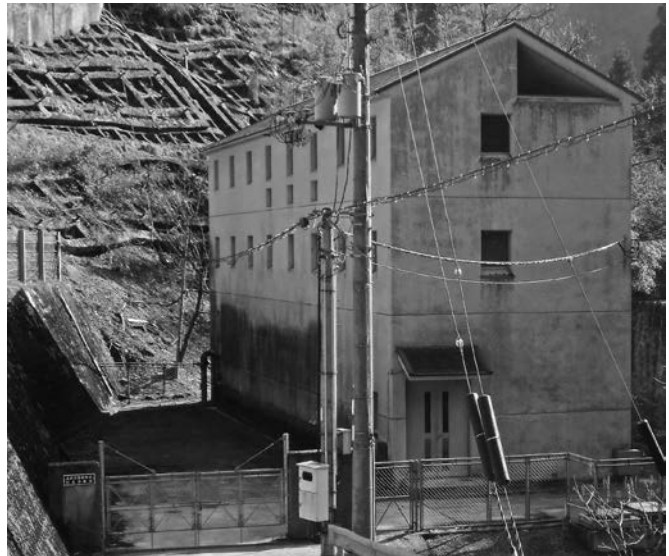
給水が止まった射添浄水場
