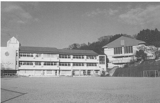
▲大規模改修を行う柴山小学校の校舎
