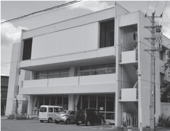
▲建て替え工事を行う香住文化会館
