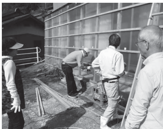
▲雪囲い作業を行う空き家所有者と入居予定者
