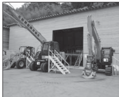
▲完成した木質バイオマスセンターと作業用機械
