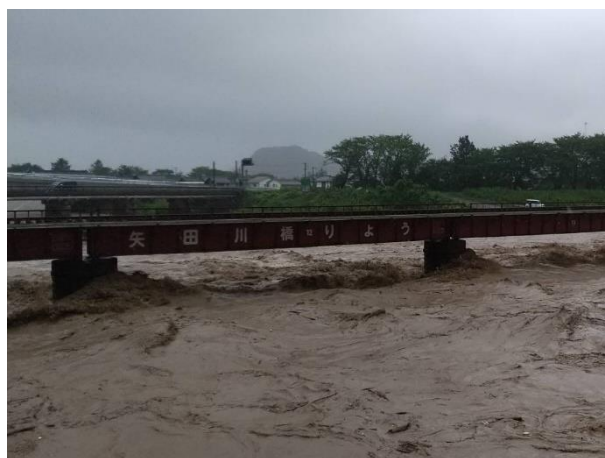
令和 5 年 8 月台風 7 号に伴う豪雨で増水した矢田川。
