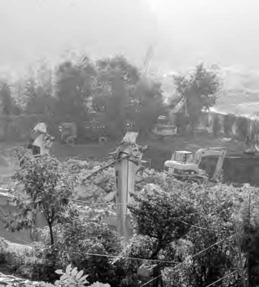
御殿山の解体終了まじかな旧村高体育館
