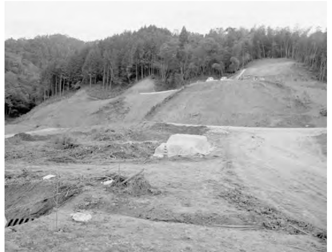
敷地の造成工事が進む北但ごみ処理施設
