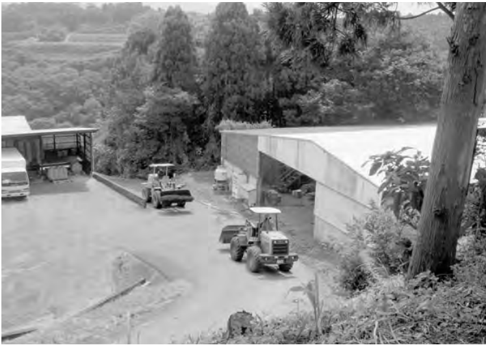
志布志市 生ゴミ・汚泥等堆肥化施設
