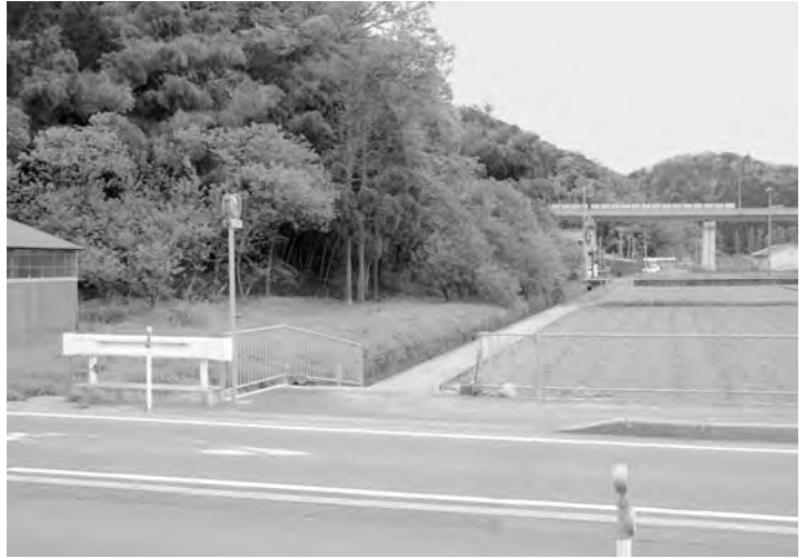
町道森道路を庁舎前に接続だ
