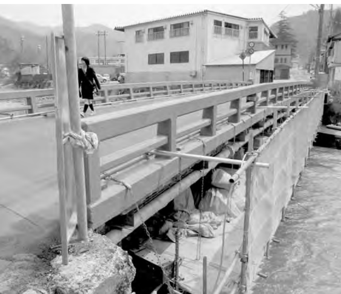
橋梁長寿命化事業で改修工事の湯舟橋（村岡区）
