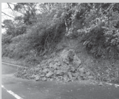
▲昨年12月に発生した香住区御崎のがけ崩れ
