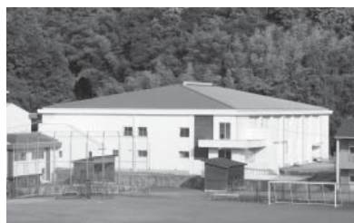
▲改修工事が完成した体育館
