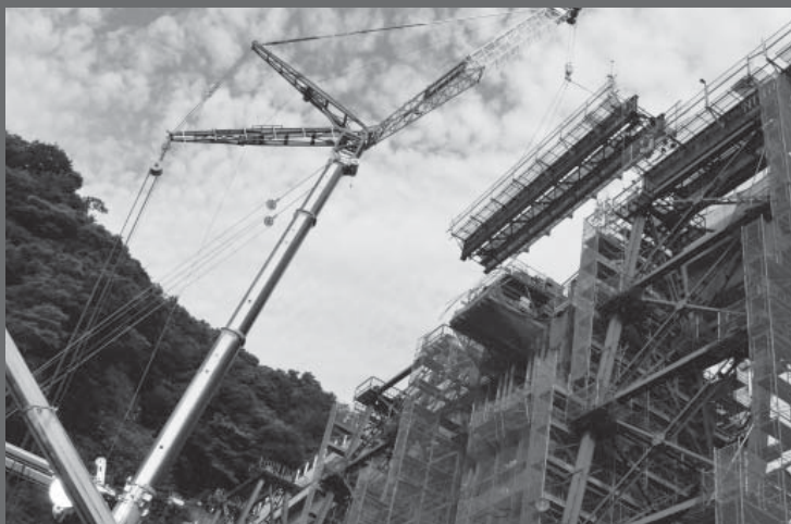
▼撤去される余部鉄橋の橋桁（今年7月17日撮影）
