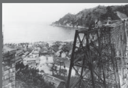
▲建設途中の余部鉄橋（明治44年撮影）
