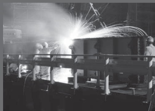
▲解体される余部鉄橋の橋桁（今年7月17日深夜撮影）
