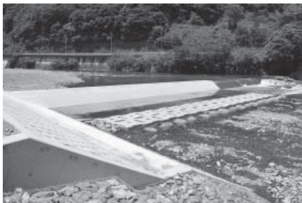
▲完成した中野井堰(矢田川右岸側から撮影)
