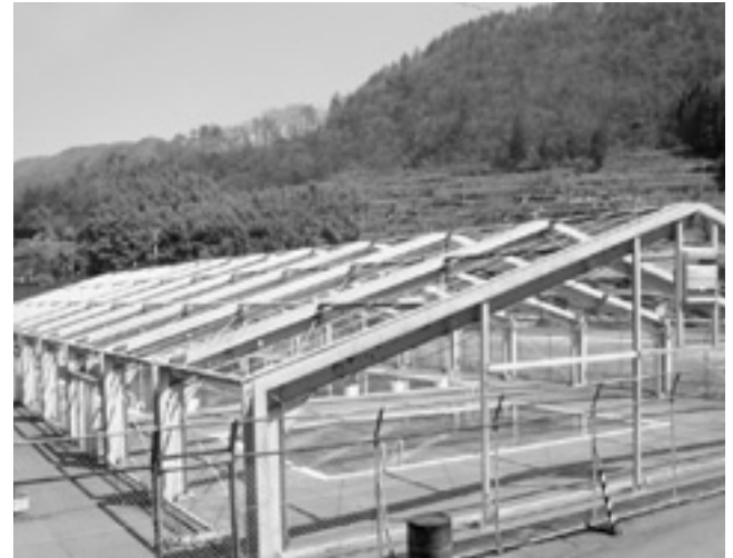
改修をせまられる屋根
