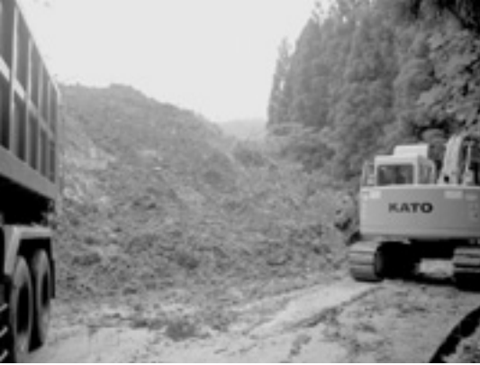
災害復旧現場 (宿地内)
