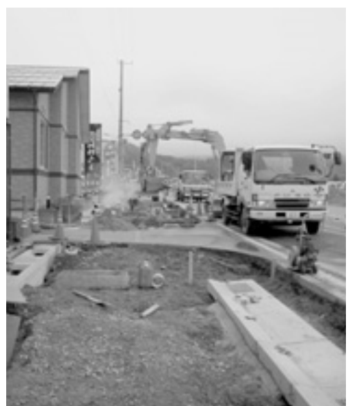
香住港湾線自歩道整備工事
