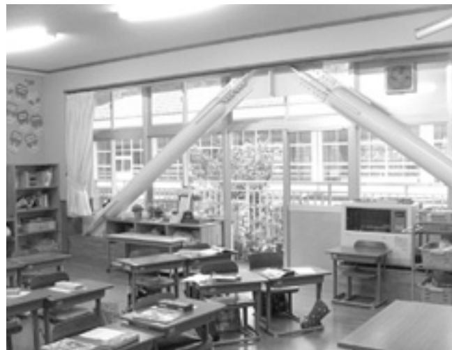
改修された射添小学校
