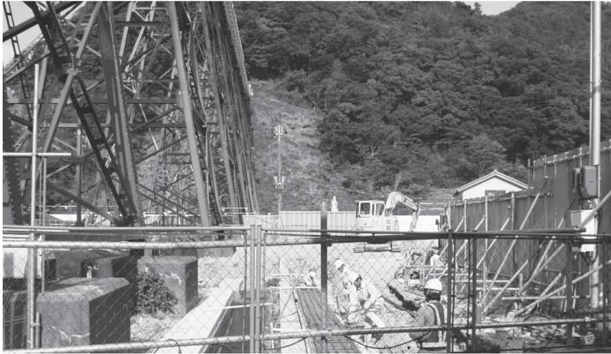
▲鉄橋下の既設水路を工事に用通路として使用するためのふたかけ工事（P2エリア）
