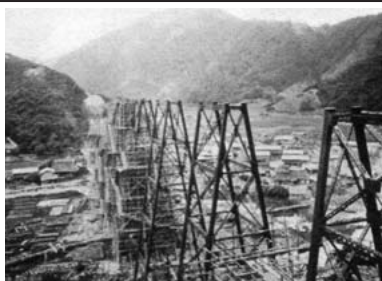
余部鉄橋工事中の風景 (絵はがきとして頒布されたものから引用)
