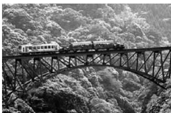
▲第一白川橋梁〔南阿蘇鉄道〕 上路バランストアーチ橋 長さ166m、昭和3年(1928)完成
