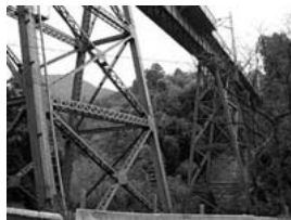
▲軍畑橋梁(奥沢橋梁)(JR青梅線) 上路プレートガーダー、鋼トレスル橋長さ105m、昭和4年(1929)完成
