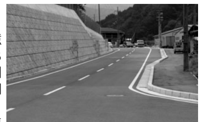
1車線から2車線に拡幅され通行しやすくなった町道石寺新屋線【美方町】
