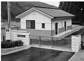
作山浄化センターの竣工で村岡町内の下水処理施設は全て建設が終わりました【村岡町】
