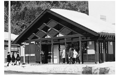
全但バス旧村岡営業所跡地に整備された地域案内センター【村岡町】
