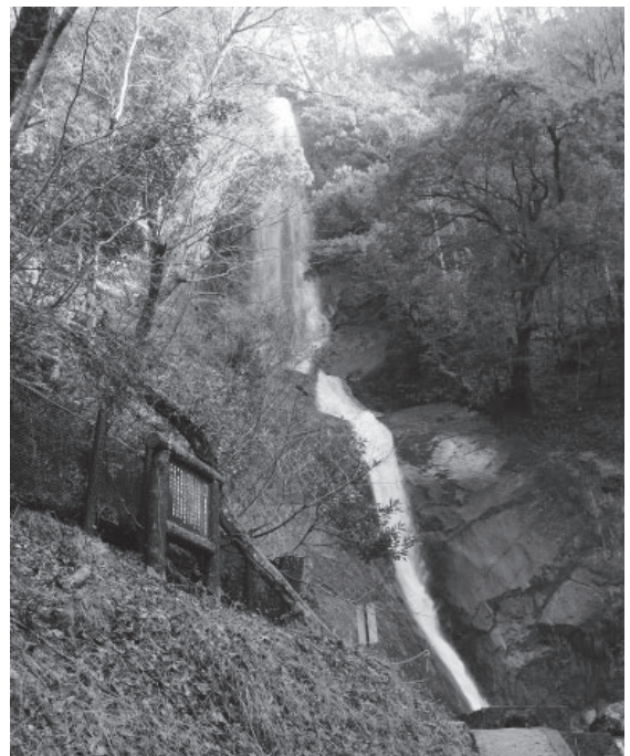
▲遊歩道落石対策工事を行う猿尾滝
