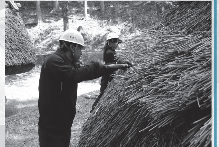
▲新しいカヤを差し込み、真剣に修繕作業を行う参加者
