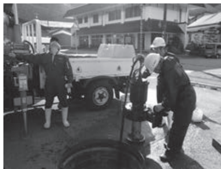
▲ポンプ分解作業
