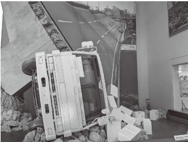
阪神・淡路大震災(国道43号道路倒壊再現模型写真)
