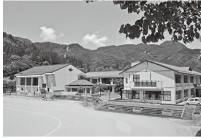
改修予定の小代中学校
