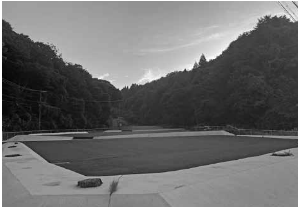
矢田川クリーンセンター跡地の管理状況
