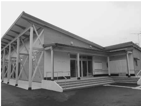
新築された下浜区公会堂
