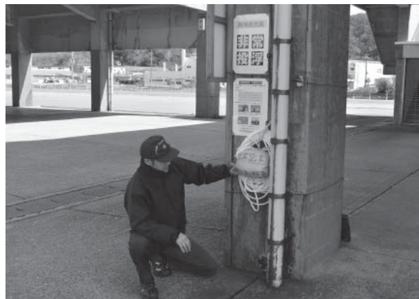
▲非常投浮を設置する香住海上保安署の署員
