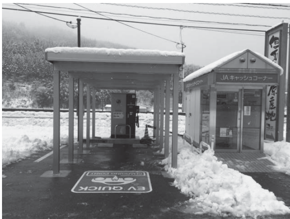
▲村岡ファームガーデンに設置した電気自動車急速充電器
