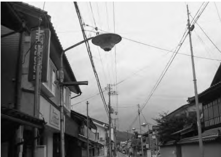
危機!! 老朽化が進む街路灯
