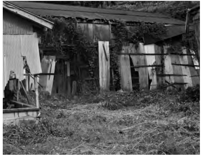
廃屋となった空き家
