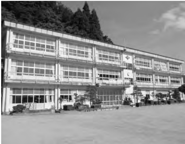
耐震化工事を待つ長井小学校
