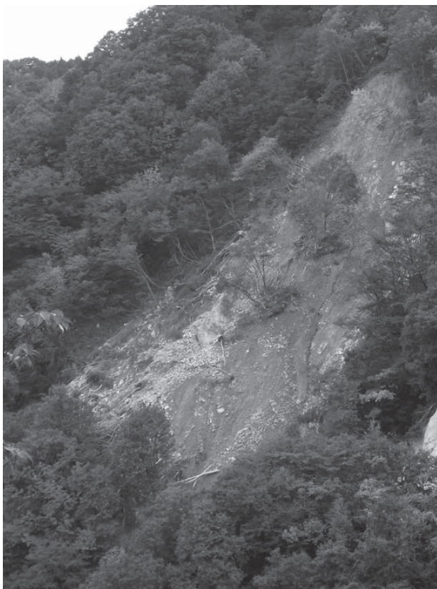
▲昨年9月30日から10月1日にかけての台風17号による豪雨で発生した、森林管理道本谷線（村岡区長瀬地内）でのがけ崩れ
