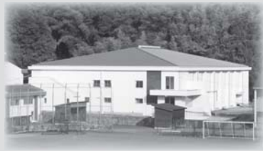
▲昨年10月末に改修工事を終えた香美町第一中学校体育館
