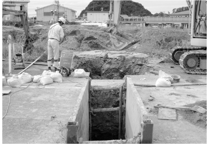
未接続に苦慮しています(妙案は)
