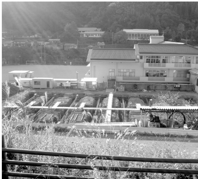
完成がまちどおしい体育館
