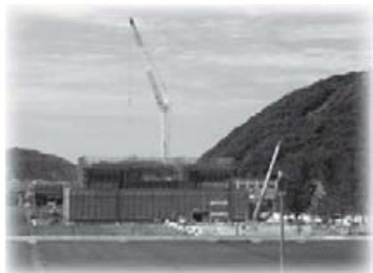
香住区では、昨年10月に着工した新庁舎建設工事が、本年11月末の完成へ向けて急ピッチで進んでいます。工事の進ちよく率は約60%（7月末現在）で、主要な躯体工事がほぼ完了し、今後は内外装機械設備などの工事を進めていきます。
