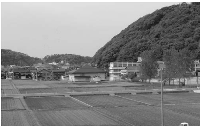
新庁舎建設予定地の現況（中央が香住学校給食センター、右奥が町立香住第一中学校）
