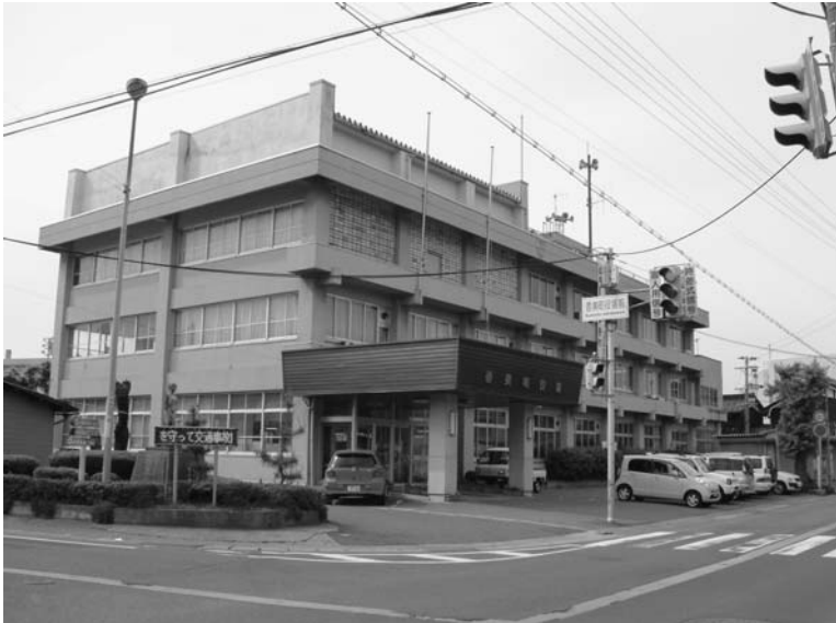
道路の拡幅工事のため移転する必要がある香美町役場本庁舎（旧香住町役場）
