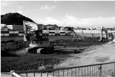
造成作業が行われている建設地
